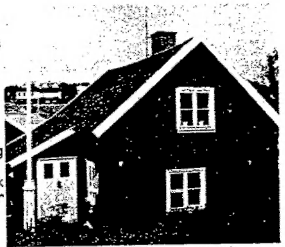
Enkelstuga med "skygga" på långsidan.
