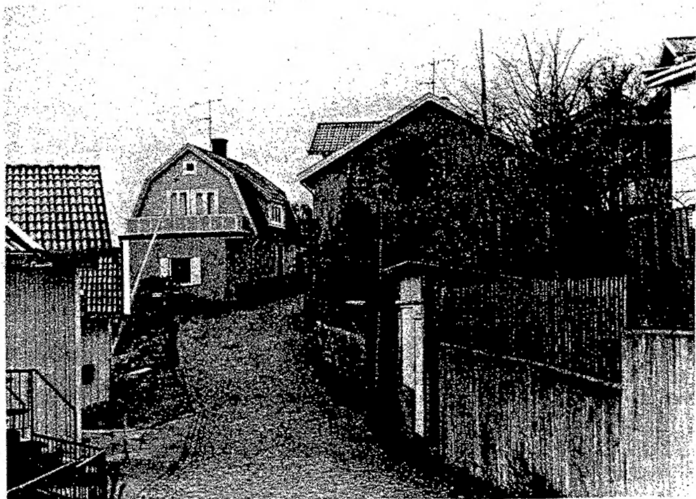
Samma parti idag. Gatan har breddats och belagts med gatsten. Trädgårdarna på vänster sida är borta. En större utfyllnad med stödmur i betong har gjorts på höger sida. Enkelstugan är riven och ersatt med ett något större hus med mansardtak. Läs märke till att det lilla skjulet är kvar!
